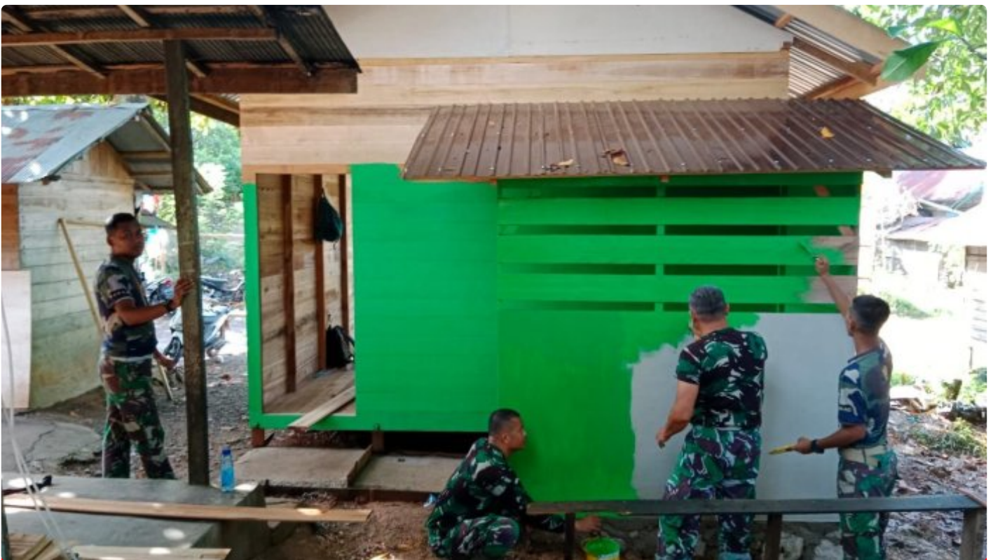
Rehab RTLH TMMMD ke-116 Kodim 1002/HST Masuk Tahap Pengecetan
