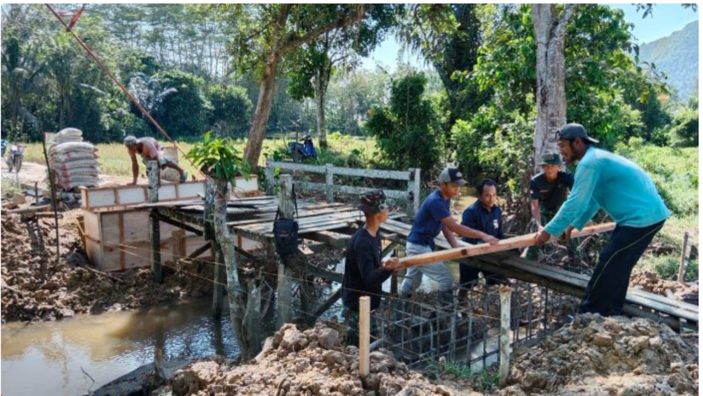
Progres Pengerjaan Jembatan, Satgas TMMD Cor Abutment
