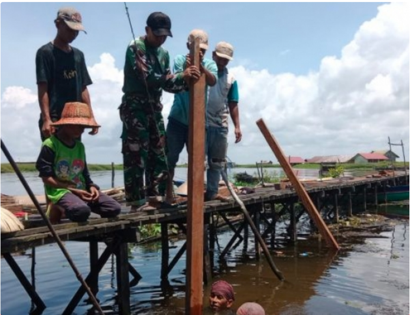
Pemasangan Tiang Penampungan Air
