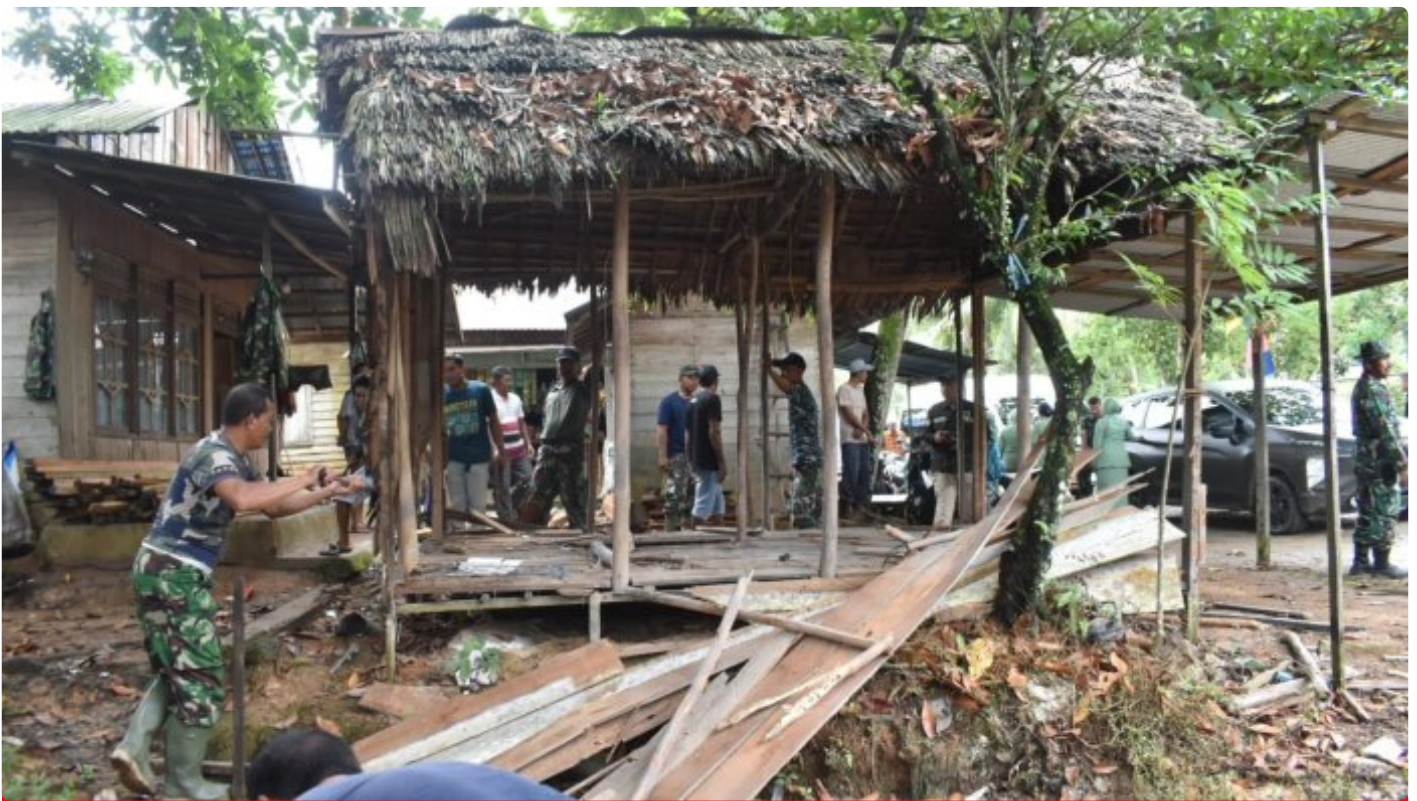
Anggota TNI Bongkar Rumah Warga Di Lokasi TMMMD ke-116 Kodim 1002/HST
